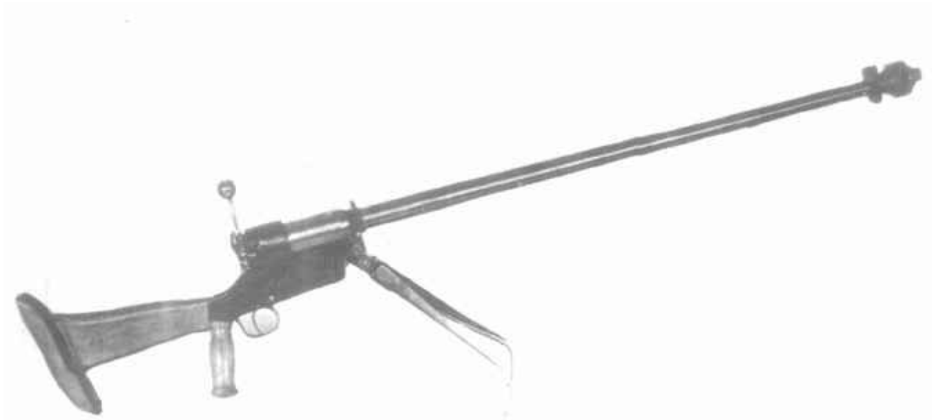
12,7-мм противотанковое ружье системы Рукавишникова, опытный образец 1942 г.
