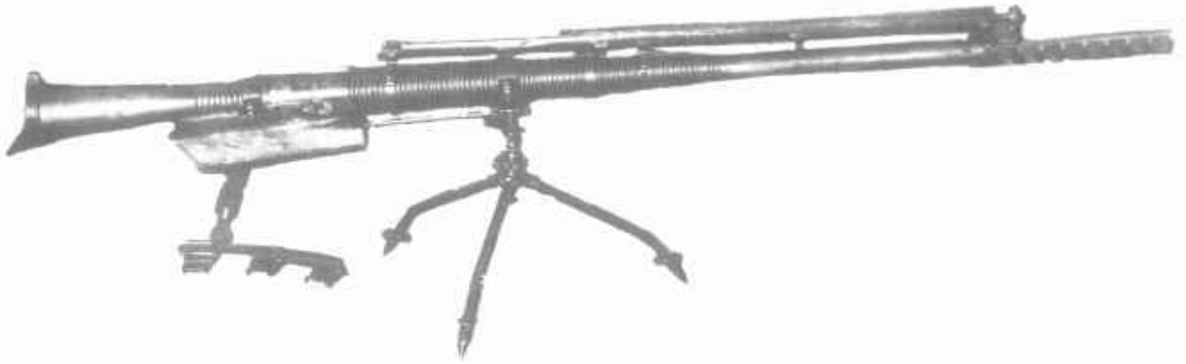
37-мм динамо-реактивное противотанковое ружье системы Курчевского образца 1932 г.
