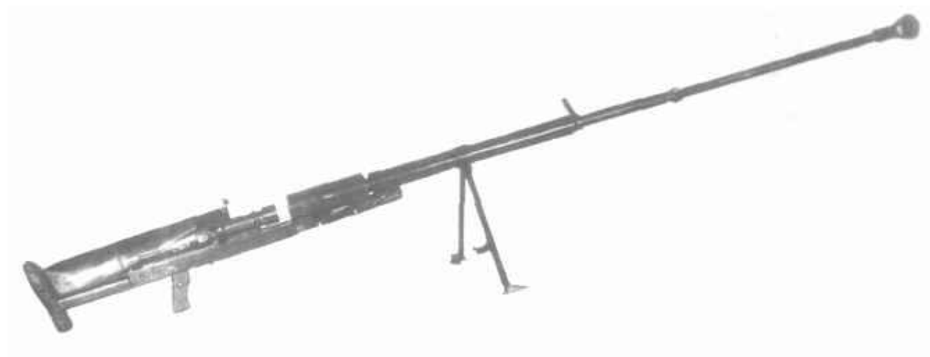
20-мм противотанковое ружье системы РЕС (Рашкова, Ермолаева, Слухоцкого), опытный образец 1942 г.
